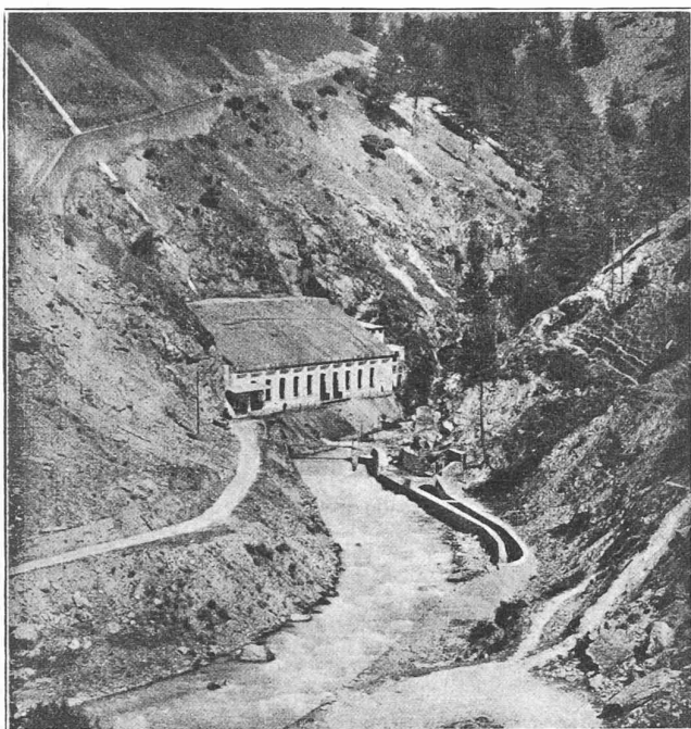
Fig. 10. — Partie de la conduite et bâtiment des machines de l'usine de Klösterli.
