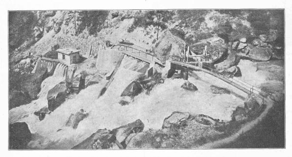
Fig. 9. — Prise d'eau de l'usine de Klösterli sur la Lonza, à Mittal.
