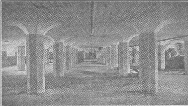
Plancher sans nervures, système Maillart. — Sous-sol d'entrepôt.
