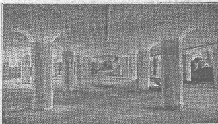
Plancher sans nervures, système Maillart. — Sous-sol d'entrepôt.
