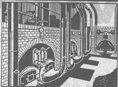
Installation de soufflerie sous grille « Fœhn » pour combustibles pauvres.
