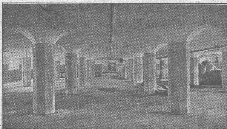
Plancher sans nervures, système Maillart. — Sous-sol d'entrepôt.
