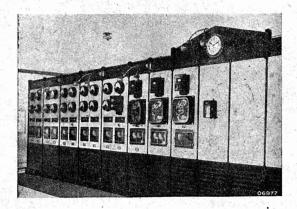
Centrale de Buenos-Aires; tableaux de distribution avec 3 régulateurs de tension pour 3 groupes turbo-alternateurs de 6250 KVA, 7000 volts.
