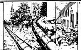
Conduite sous pression de la Fonderie électro-métallique P. Peters, Mühlheim (Thurgovie). Conduite, longue de 200 m., formée de tuyaux en ciment de 60 cm. de diamètre, perdait fortement. Au moyen d'une ENDUIT SIKA étanchée et mise immecouche intérieure de
