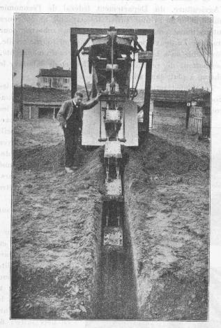
Fig. 3. — Le tracteur Scheuchzer fonctionnant comme autodraineuse.
