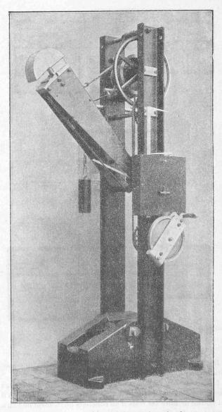
Fig. 27. — Mouton-pendule, système Amsler.
