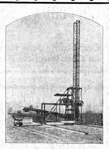
Louchet à commande électrique avec tablier métallique.
