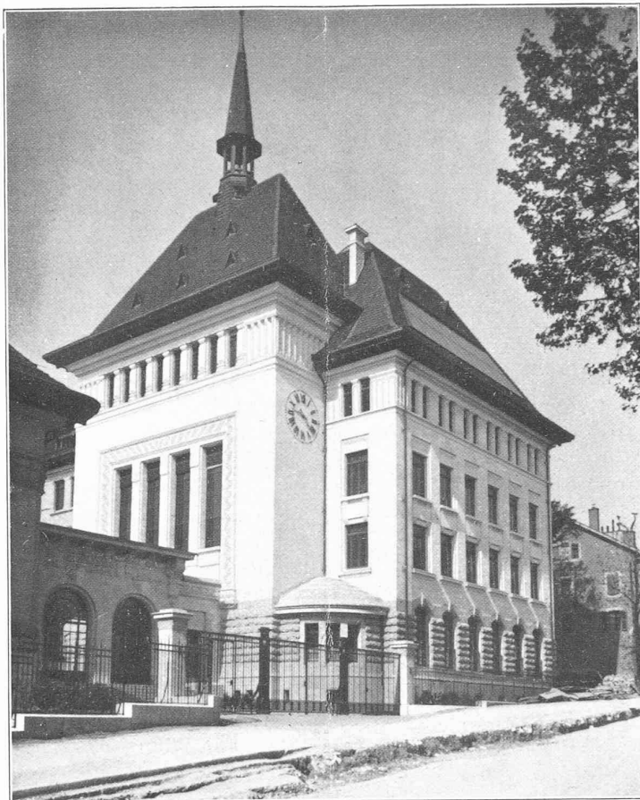
Façade sur la rue Voltaire.
