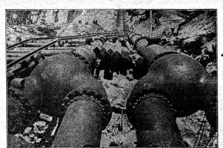
Conduite de turbine de Big Creek (Californie). Transition de deux conduites de tubes sur quatre au moyen de tubes Y fonte acter. Poids total de la fourniture: 8,700 tonnes.
