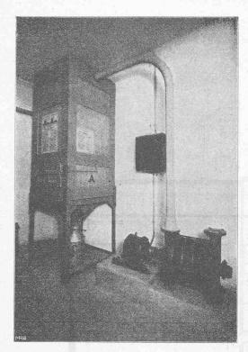
Fig. 23. — Installation pour l'évacuation de poussières avec ventilateur centrifuge multicellulaire à haute pression.
