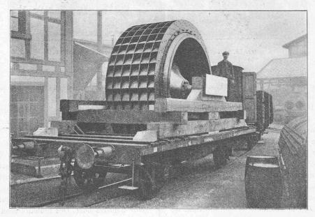
Fig. 48. — Roue à ailettes des nouveaux ventilateurs centrifuges du tunnel du Simplon.
