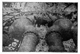
Conduite de turbine de Big Greek (Californie). Transition de deux conduites de tubes sur quatre au moyen de tubes Y fonte acier. Poids total de la fourniture: 8,700 tonnes. ont fourni jusqu'à présent
