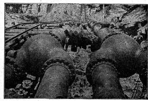
onduite de turbine de Big Creek (Californie). conduites de tubes sur quatre au moyen de tubes Y fonte acier. Poids total de la fourniture : 8,700 tonnes.
