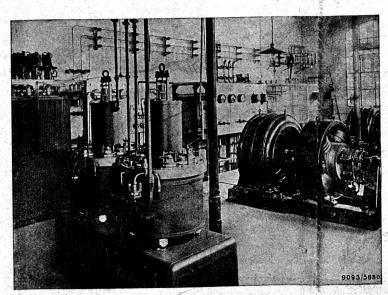
Convertisseurs dans la Salle centrale des Tramways, à Schliegen. Puissance 150 kW . Tension 600 Volts.
