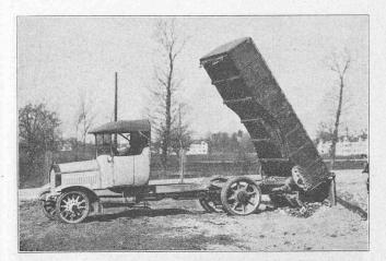
Fig. 11. — Camion pendant le basculement de la benne.
