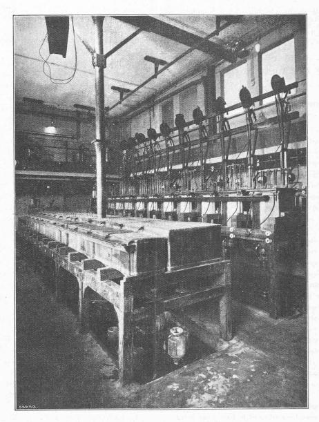
Fig. 6. — Installation pour l'affinage de l'argent.
