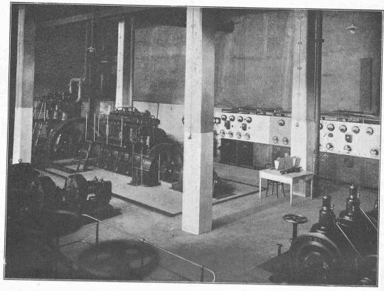
Fig. 7. - Moteurs Diesel. - Machine à vapeur - Tableau.
