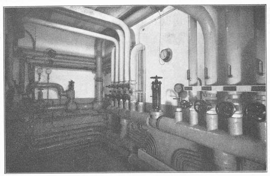
Fig. 8. — Appareils de distribution de la vapeur.
