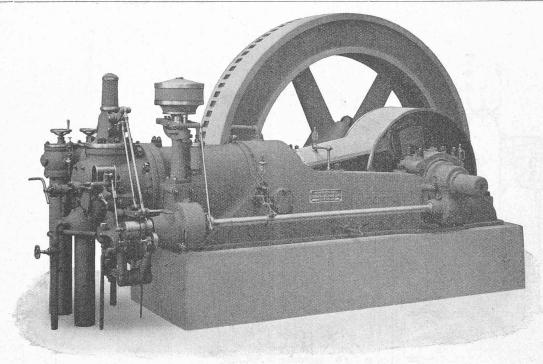
Fig. 73. — Moteur à gaz horizontal de 40 HP.
