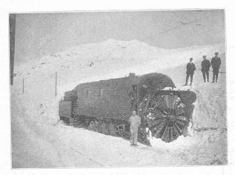
Fig. 61. — Chasse-neige faisant corps avec la locomotive.
