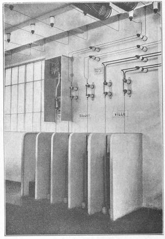
Fig. 26. - Vue d'une partie des condensateurs.
