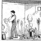
out emplacement situé sous eau est rendu imperméable par l'emploi du sika rapide.
