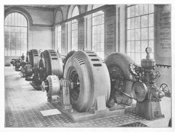
Fig. 21. - Groupes électrogènes de 1350 HP.
