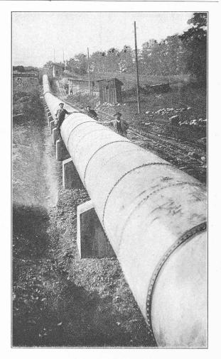
Fig. 15. — Vue de la conduite forcée.
