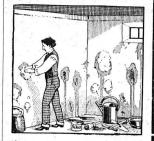
out emplacement situé sous eau est rendu imperméable par l'empioi du sika rapide.
