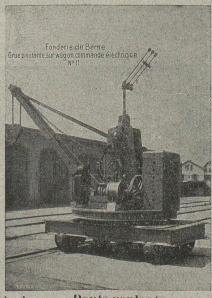
Appareils de levage: Ponts roulants, grues pivotantes, commande à bras et commande électrique, monte-charges, appareils de levage pour essieux, monte-charges pour charbon pour approvisionner les locomotives.
