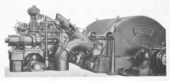
Fig. 16. — Turbine Pelton de 16 400 HP, pour l'usine de Saaheim.
