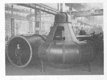
Fig. 9. — Turbine Francis simple, à axe vertical. destinée à l'Usine de Séros.  $H=47~\mathrm{m}$ , ;  $N=15~000~\mathrm{HP}$ ;  $n=250~\mathrm{t./min}$ .
