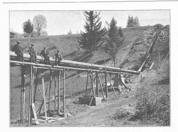
Fig. 5. — Partie surélevée de la conduite.
