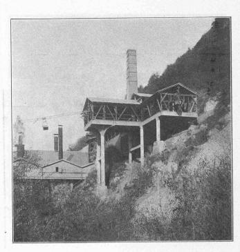
Fig. 9. — Station d'angle de la voie aérienne.
