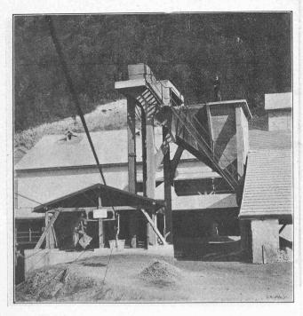
Fig. 11. - Station d'arrivée du transport aérien.
