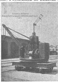
Appareils de levage: Ponts roulants, Grues pivotantes ou électrique. Monte-charges hydrauliques, électriques ou à courroie.
