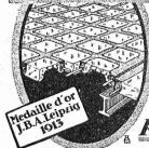
SYSTÈME KEPPLER BREVETÉ Nouveau système de plafonds translucides en béton armé et dalles de verre
