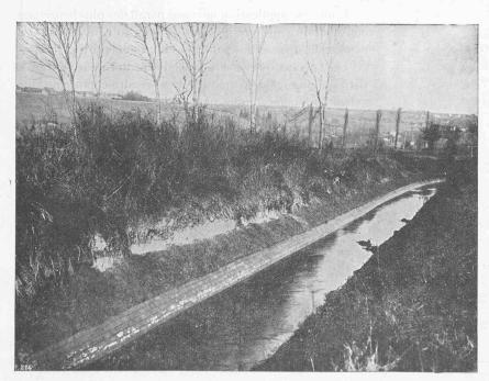
Fig. 8. - Protection exécutée au Fossé-Neuf, à Salavaux.
