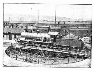
Pont tournant électrique, de 20 m. gare Zurich.
