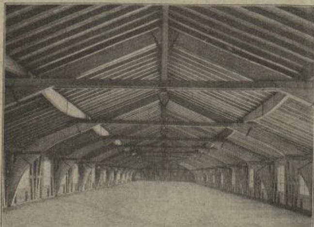
Poutres composées paraboliques pour de grandes surcharges et pour portées jusqu'à 8 m.
