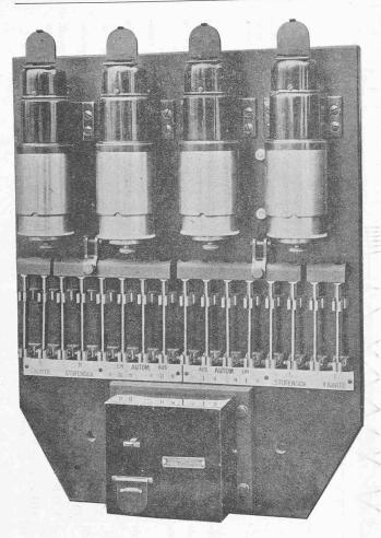
Fig. 14. — Tableau de distribution des relais.
