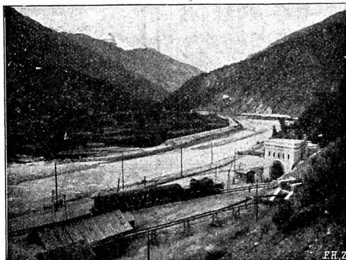
Portail Nord du Tunnel du Simplon.
