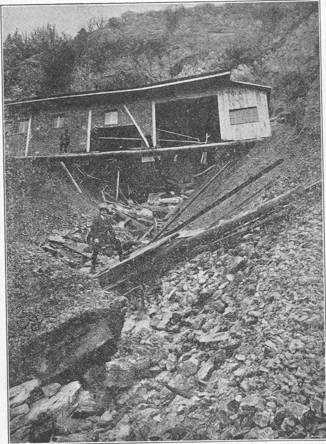
Fig. 24. — Le bâtiment des bains, après l'inondation.
