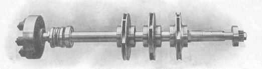
Flg. 9. - Arbre de pompe avec roues mobiles d'une pompe centrifuge à incendie Sulzer.
