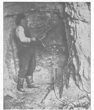
Marteaux perforateurs à air comprimé.
