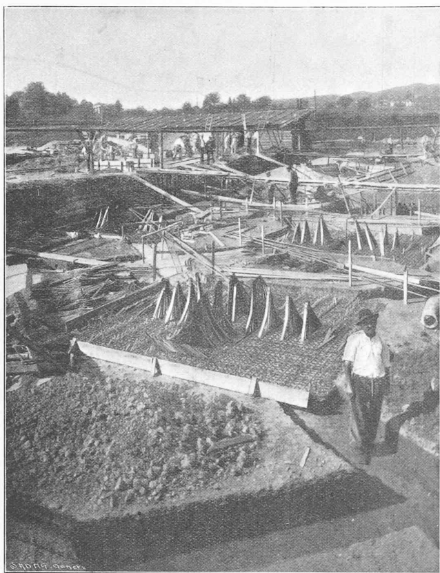
Fig. 7. — Fondations des colonnes en béton armé des magasins à charbon.
