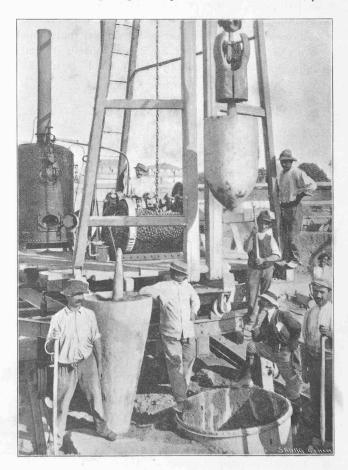
Fig. 8. — Bourrage d'un puits par le système Compressol.
