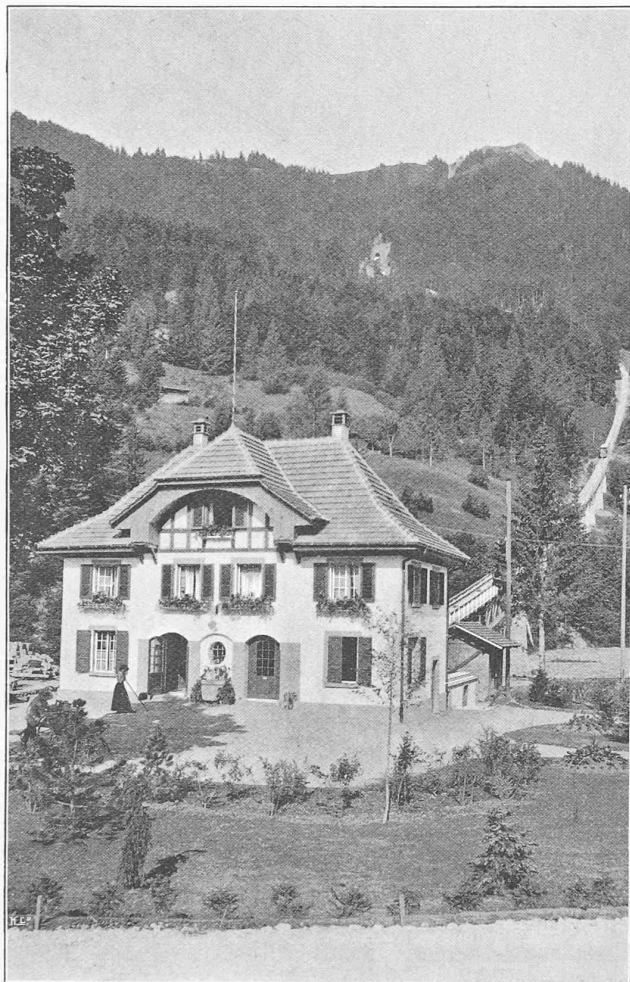
Fig. 22. — Station de Mülenen.
