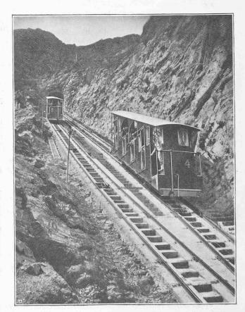
Fig. 14. - Evitement de la IIº section.
