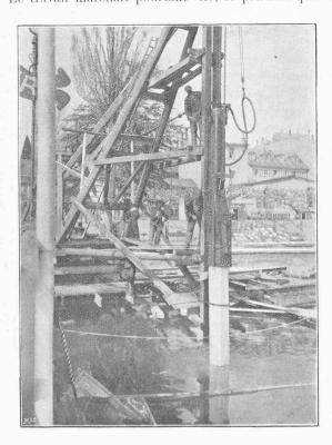
Fig. 3. — Fonçage d'un pieu.
