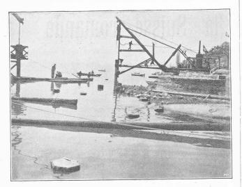
Fig. 2. - Fonçage d'un pieu.
