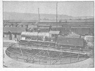
Pont tournant électrique de 20 m., gare Zurich.
