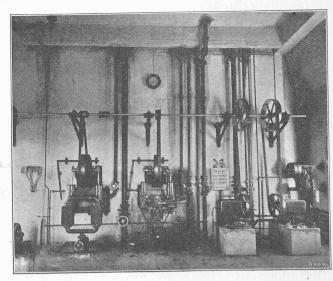
Pompe à goudron. Pompe à ammoniaque. Pompe à eau. Compresseur Fig. C8. — Pompes.
