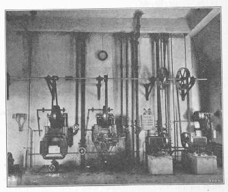
Pompe à goudron. Pompe à ammoniaque. Pompe à eau. Compresseur Fig. 68. — Pompes.
