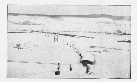
Chemin aérien servant au transport de basalte pour les » Ohmtal-Basaltwerke« anc. maison Kanitzer & Pistor, Marburg s./Lahn, Usine de Niederofleiden. Longueur de la voie: 700 m.
