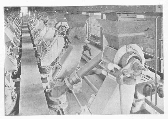
Fig. 49. — Dessus des cornues avec appareil de charge.
