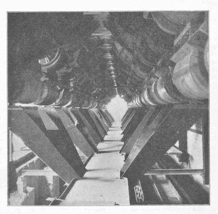
Fig. 54. — Fours. — Dessous des cornues avec goulottes de décharge.
