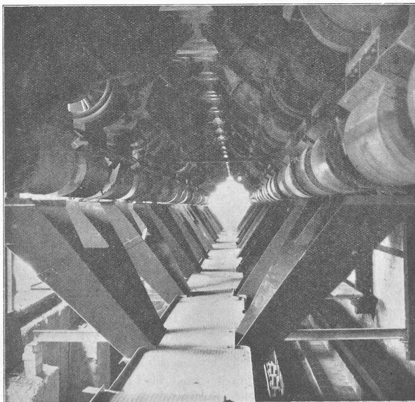
Fig. 54. — Fours. — Dessous des cornues avec goulottes de décharge.
